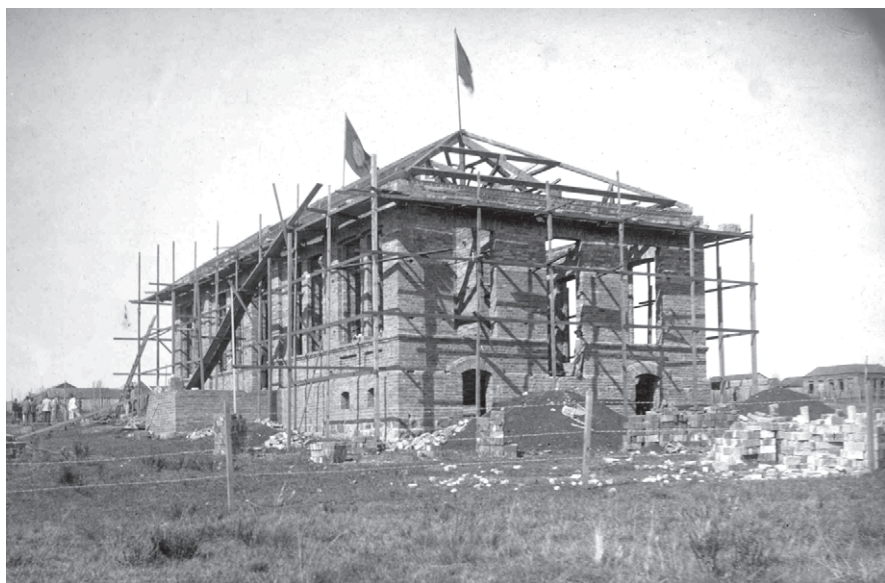
Primeiro prédio do Hospital de Caridade de Passo Fundo, em construção. Década de 1910.
