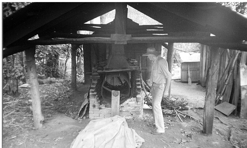
Método artesanal de produção de calor (carijo) para secagem da erva- mate na residência do sr. José Pertile. Marau.
