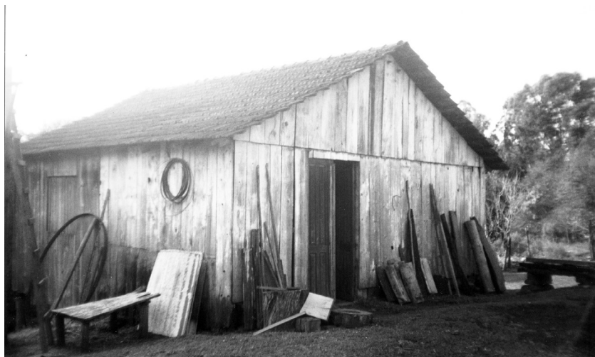
Galpão utilizado para confecção de pipas e barris artesanalmente em madeira - Marau.
